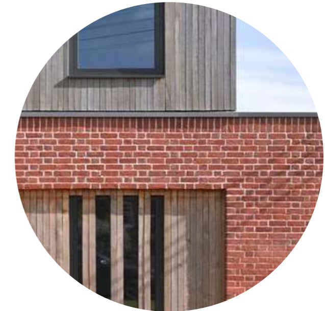
Materiale skift i facaden.
