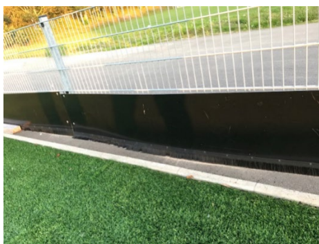
Foto af barrierer i forbindelse med hegn – monteret med børster. Højre billede er set umiddelbart ovenfra. 46
