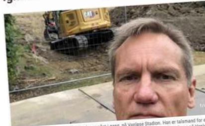
Bjørn Skjoldbye står foran byggepladsen, der er gået i gang, på Vanløse Stadion. Han er talmand for en gruppe på over 500 borgere, der er utilfredse med etableringen af den nye kunstgræsbane på Vanløse Stadion. Foto: Privat
